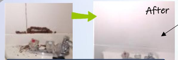
浴室壁内部からの腐食穴… 錆処理をしてからの補修!!
